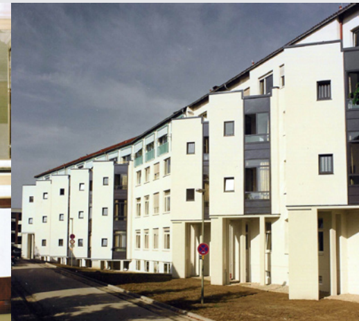
Neue Fassade durch Vorbau von Turmelementen
